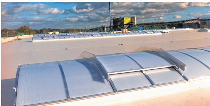
Palme belegt Dach der Halle von SSL mit Photovoltaik-Modulen.
